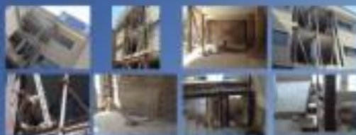
پارسیب اینارهای آهنی در محل آجرهای اینارهای برشته و در بعضی دیوارهای اینارهای سیم‌چوبی
