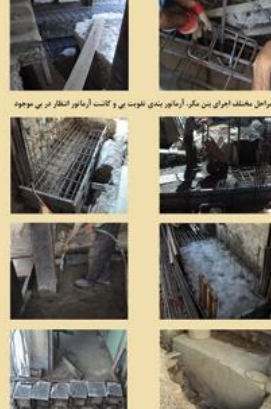
مراحل مختلف قالب بندی و بتن ریزی فونداسیون و نمونه برداری برای کنترل کیفیت و مقاومت بتن
