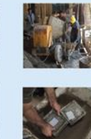
مراحل مختلف اجرای بتن مگر، آماده‌سازی بتنی پوسته سی و کاسبت آماده‌سازی انتظار بر پی موجود
