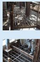
مراحل مختلف اجرای بتن مگر، آماده‌سازی بتنی پوسته سی و کاسبت آماده‌سازی انتظار بر پی موجود
