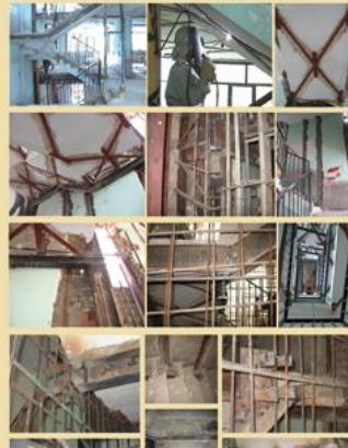
مراحل آرماتوربندی، قالب بندی و بتن ریزی دیوار برشی در طبقات
