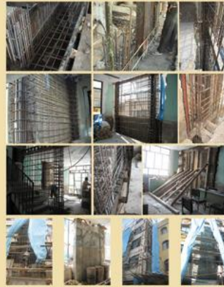
مراحل آرماتوربندی، قالب بندی و بتن ریزی دیوار برشی در طبقات
