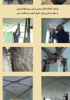
مراحل مختلف ایجاد انسجام و تأمین عملکرد دیوارگسی سلف تالی ضربی طبقات و اتصال آنها به دیوار برشی
